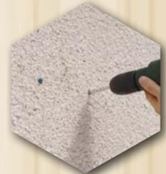
Sur une façade de bâtiment, munissez vous d'une perceuse à percussion, de chevilles et de vis de  $\varnothing 4\text{mm}$  et 60mm de long (idéalement).
