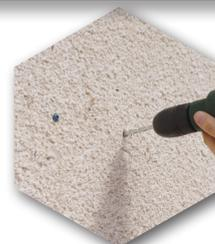
Sur une façade de bâtiment, munissez vous d'une perceuse à percussion, de 4 chevilles et de 4 vis de  $\varnothing 4\text{mm}$  et 60mm de long (idéalement).
