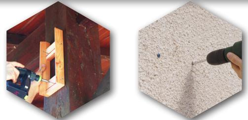
Sur une façade de bâtiment, je fais 4 trous avec une perceuse à percussion, 4 chevilles (à enfoncer au marteau) et 4 vis de Ø4mm et 60mm de long (idéalement).
