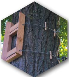
Je dispose le système de fixation sur l'arbre, passe les fils dans les boucles et torsade le fil sur lui même (sans trop serrer).
