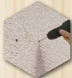
Sur une façade de bâtiment, munissez vous d'une perceuse à percussion, des chevilles et vis fournies. Placez la cale de fixation de niveau, marquez l'emplacement des trous au travers de la cale et percez le mur. Enfoncez les chevilles puis vissez la cale.
