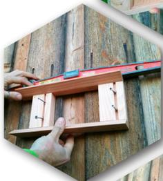
Je positionne le système de fixation de niveau avec l'emplacement de la vis tête bombée (que j'ai retirée) vers le haut.
