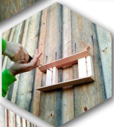
Sur une façade bois, je visse directement le système de fixation de niveau à l'horizontal. Sur une façade minérale, j'utilise des chevilles et vis (4x50mm) et je perce avec une mèche de 6 mm.
